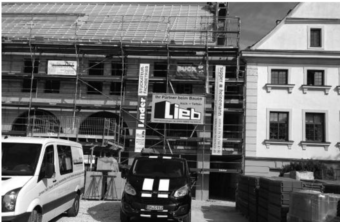
Zwischen dem historischen Schlossgebäude und dem Neubau werden barrierefreie Übergänge geschaffen, damit auch der Altbau vom zentralen Aufzug miterreichbar ist. Dazu werden an bestimmten Stellen die bisherigen Fensteröffnungen denkmalgerecht zu Türöffnungen umgebaut.
