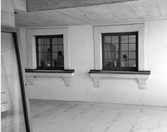
Die Innenausbauwerke am neuen Schlossflügel haben dieser Tage schon begonnen; in den nächsten Tagen werden die Fenster montiert, damit der Rohbau dicht ist und die weiteren Innenausbauarbeiten anlaufen können.
